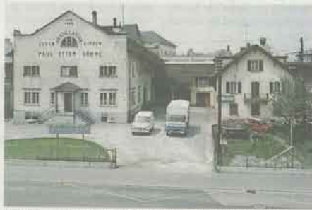
Dritter Firmensitz der «Paul Etter Söhne» beim Bahnhof an der Baarerstrasse 37 in Zug, nach 1970.
